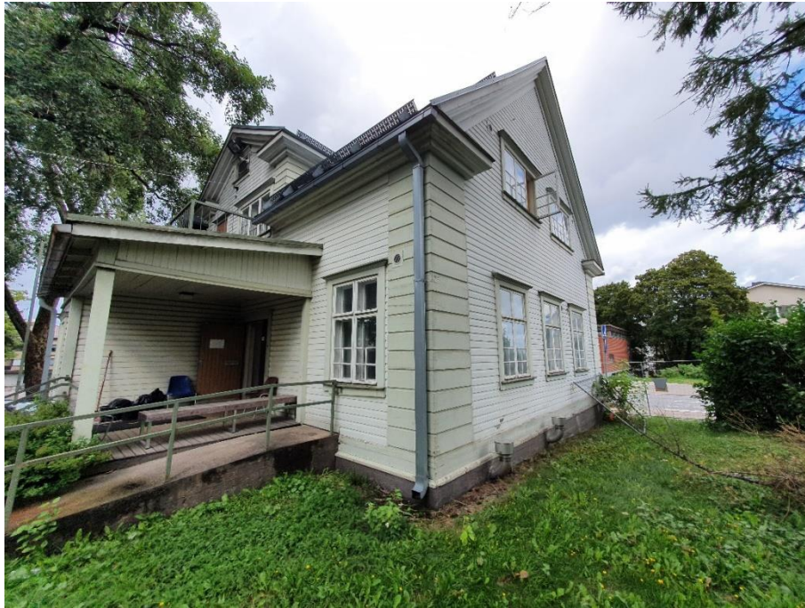
Kuva 9. Plathanin talon ulkoseinustoilta ei löytynyt merkkejä lepakoiden läsnäoloon viittaavista koloista tai lepakoiden ulosteista.
